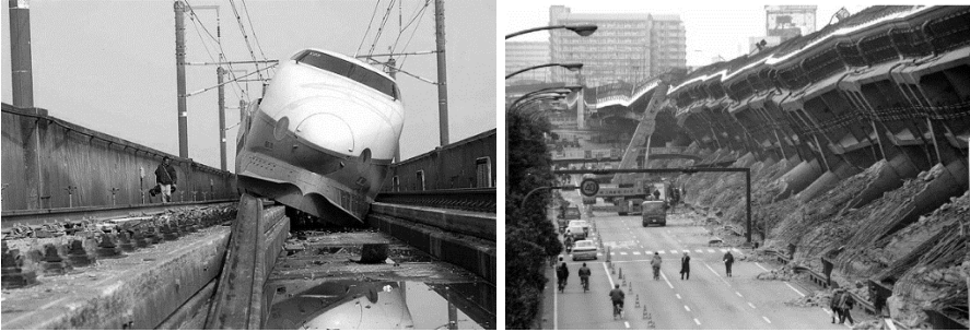
Рис. 2.9. Последствия землетрясения в Кобе
