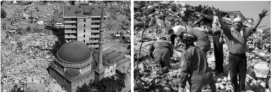
Рис. 2.10. Последствия Измитского землетрясения
