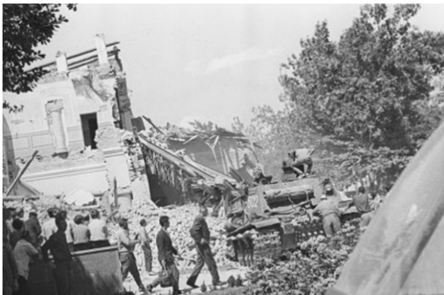
Рис.2.6. Последствия Ташкентского землетрясения
