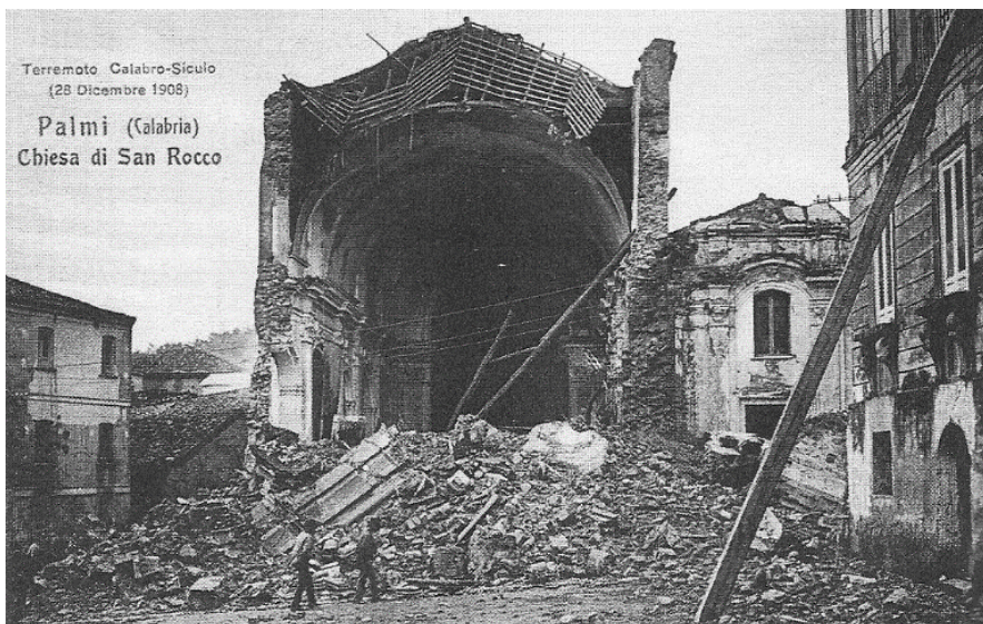
Рис. 2.1. Разрушение церкви Сан-Рокко
